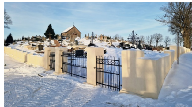
Atstatyta Užvenčio miesto civilinių kapinių tvoros betoninės dalies atkarpa
