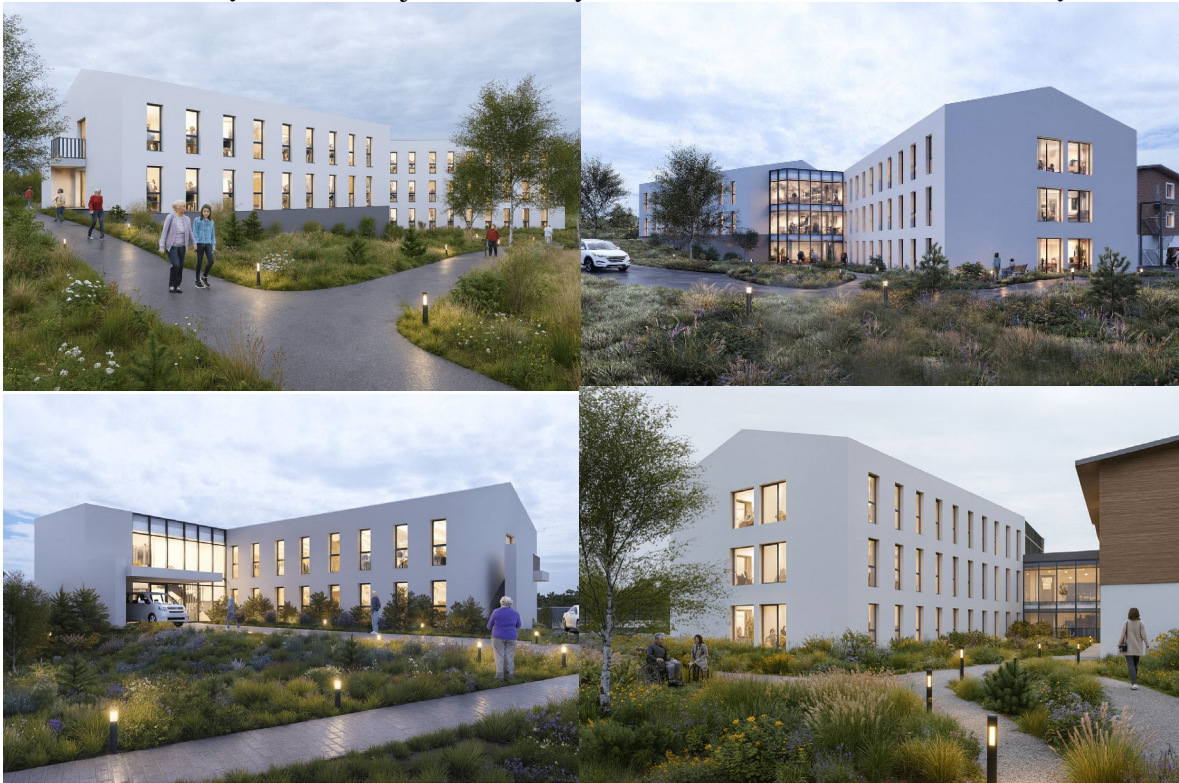
Socialinių paslaugų įstaigų senyvo amžiaus asmenims infrastruktūros modernizavimas ir plėtra
