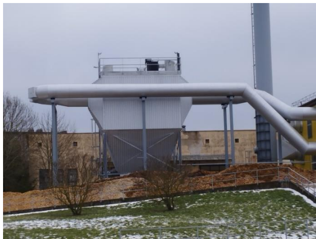
1 pav. Elektrostatinis kietųjų dalelių valymo filtras Kelmės A. Mackevičiaus g. katilinėje
