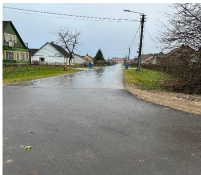
11 pav. Atlikti Pušyno g. dalies Kelmės m. kapitalinio remonto darbai
