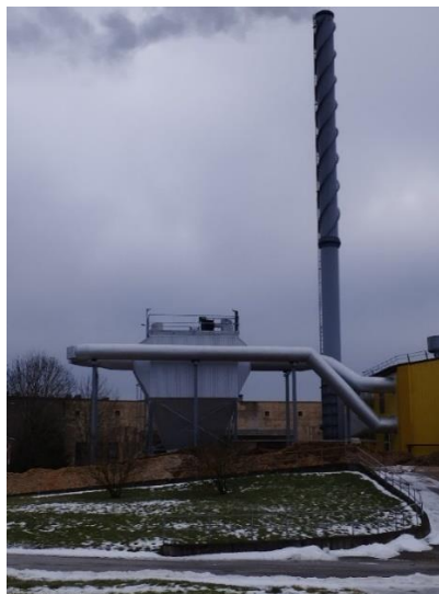
1 pav. Elektrostatinis kietųjų dalelių valymo filtras Kelmės A. Mackevičiaus g. katilinėje
